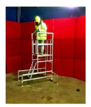
11) FIT GUARDRAIL **BRACES AT FRONT** AND BACK OF UNIT
